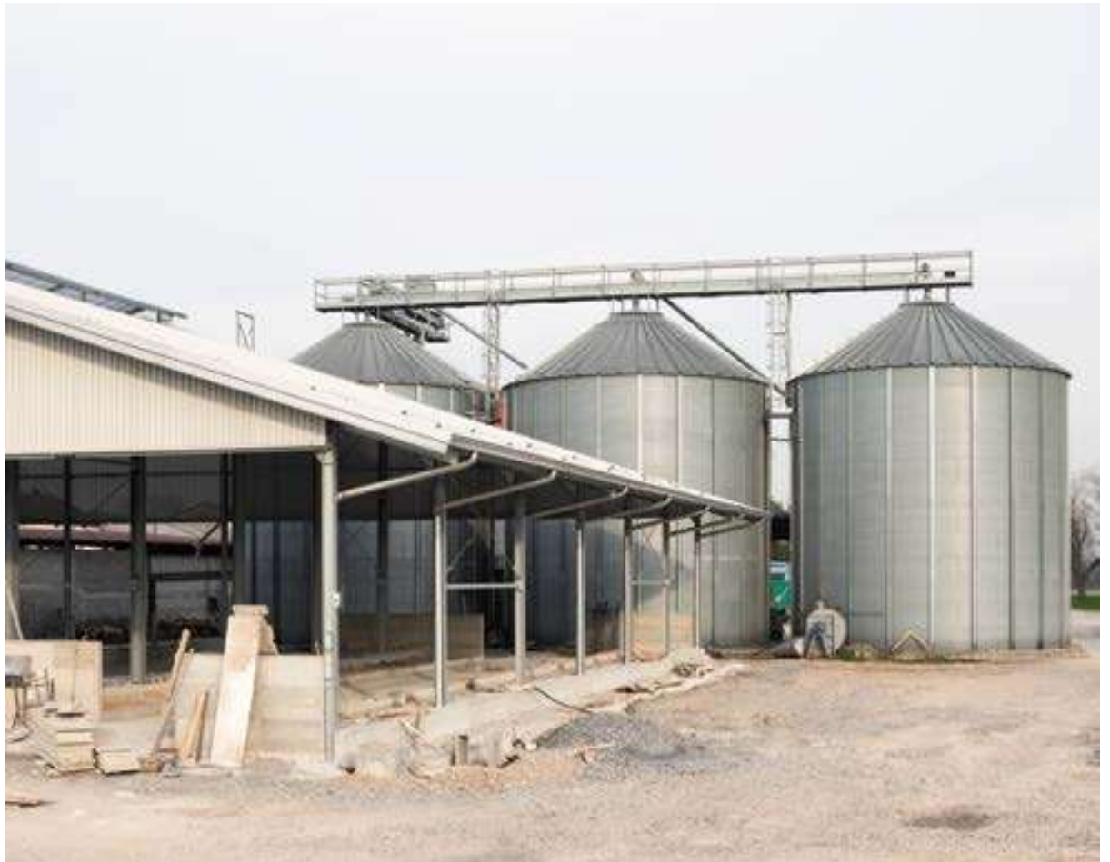
La nuova stalla in fase di costruzione che ospiterà le vacche in asciutta per migliorare ulteriormente il benessere animale
